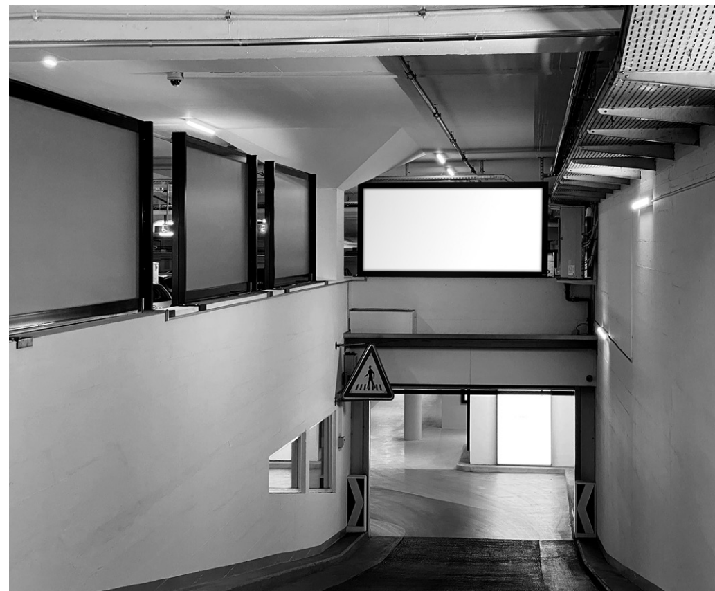
RAMPE DESCENTE ÉTAGE -1 À ÉTAGE -2
