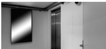
ÉTAGE -1 SORTIE TUNNEL
