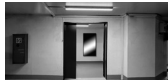
ÉTAGE -2 SORTIE TUNNEL
